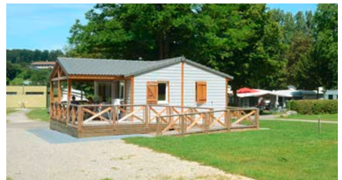
Bungalow avec accès pour fauteuil roulant.
